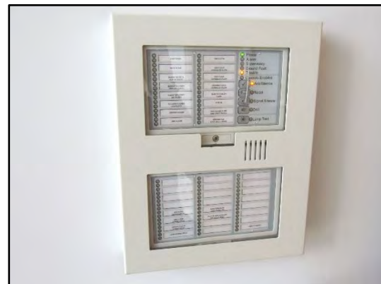
EST remote annunciator panel.
